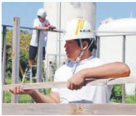
建設現場で解体作業
