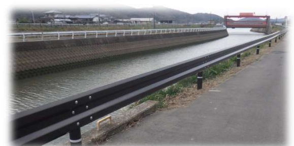
景観に配慮したガードレールの更新 （上）更新前 （下）更新後
