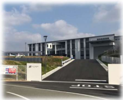
完成した工場
