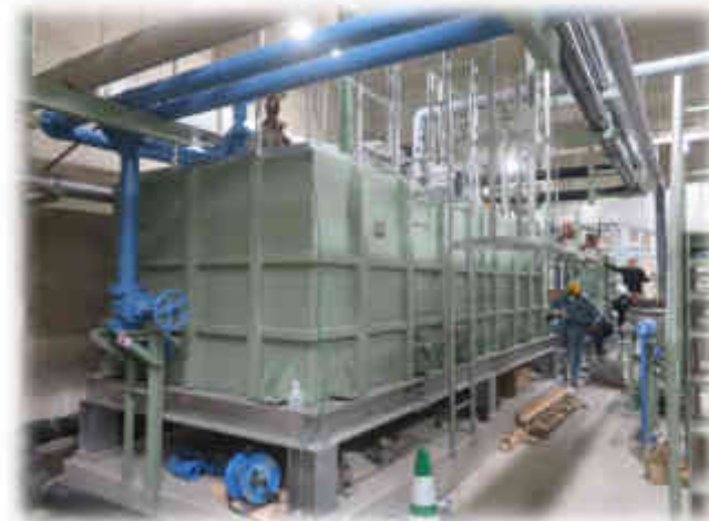
し尿受入施設の工事状況
