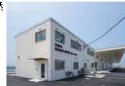
完成した高度衛生管理型荷さばき所
