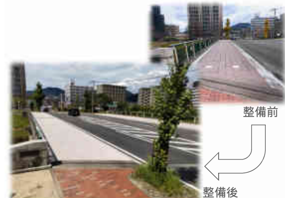
整備前 整備後 釣川に架かる赤間大橋の橋梁長寿命化工事
