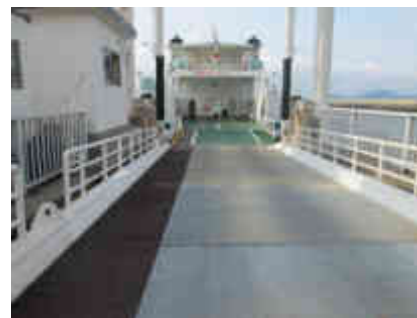
フェリー後部のバリアフリー機能向上工事 (滑り止め加工歩道と手すり延長)
