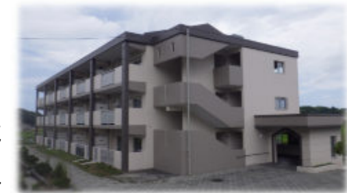
大規模改修(外壁等)改修を行った後曲団地
