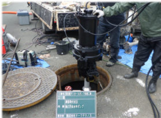
マンホールポンプ改築工事 (中の尾マンホールポンプ)
