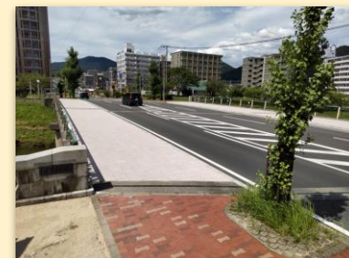
釣川に架かる赤間大橋の 橋梁長寿命化工事
