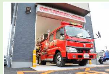
改築した第5分団格納庫
