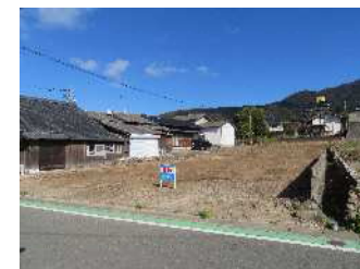
老朽空き家等除去状況
