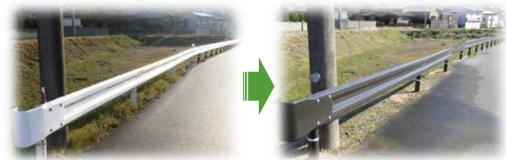
景観に配慮したガードレールの更新
