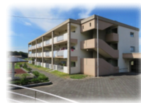
エレベーター設置を行う後曲団地
