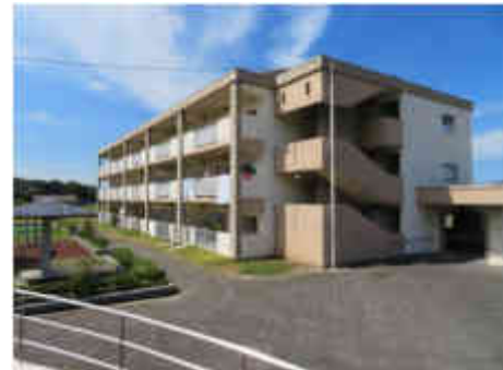
エレベーター設置を行う後曲団地 (R6年度)
