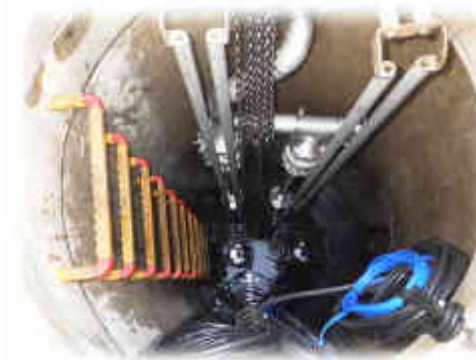
更新したマンホールポンプ槽内
