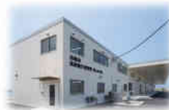
高度衛生管理型荷さばき所
