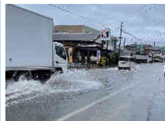
浸水状況（R5.7 田熊エリア）
