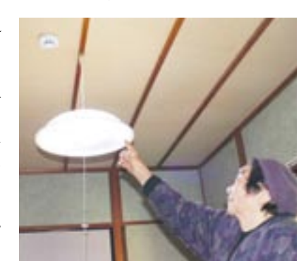
火災警報器は寝室に設置しました
