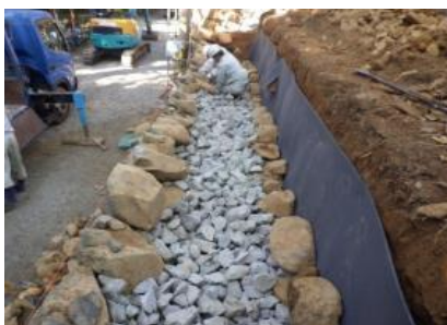
裏込め石積み
