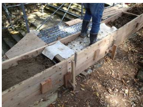
土塀土積み作業
