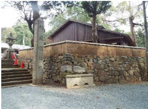
八所宮石垣及び土塀保存修復
