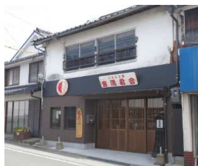
改装後物件外観
