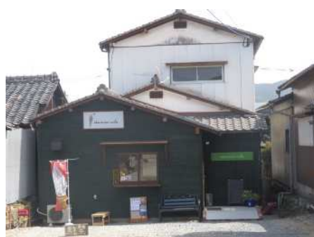
改装後物件外観
