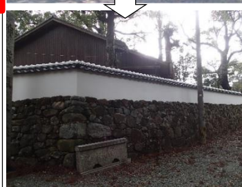
八所宮の石垣と土塀の保存修理
