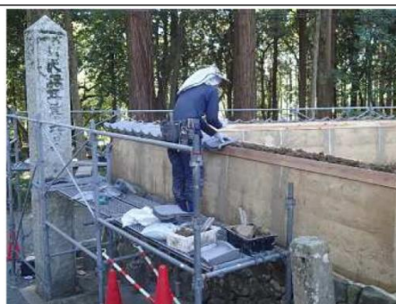
八所宮の土塀修復
