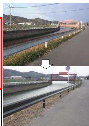
景観に配慮したガードレールの更新
