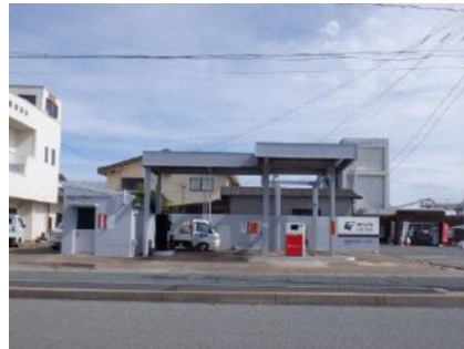
景観に配慮した色(グレー系)で修景
