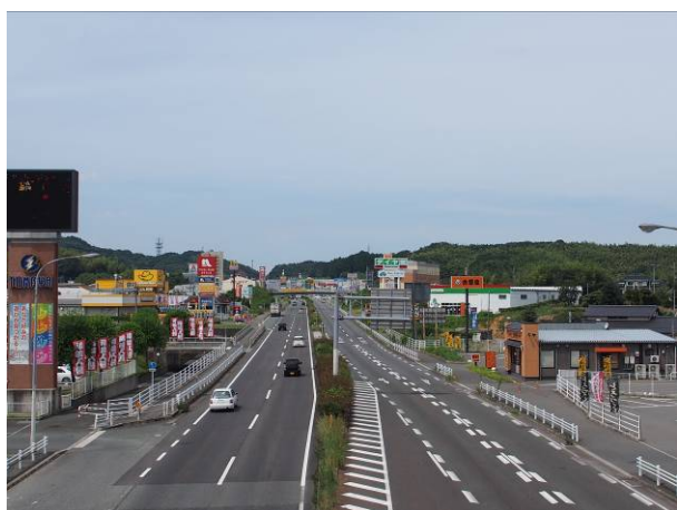
▲国道3号（光岡付近）
