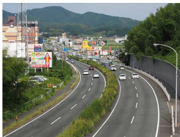
▲国道3号（徳重付近）
