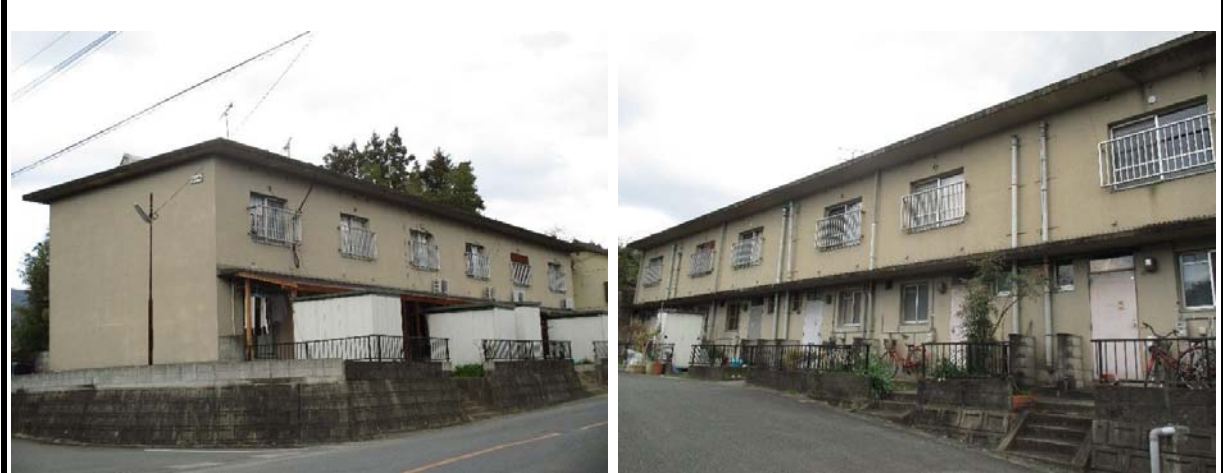
簡易耐火構造2F（庭側）
