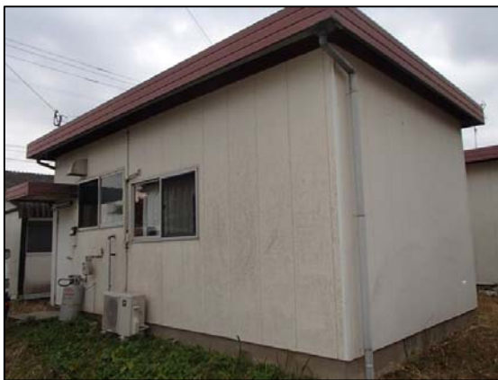
簡易鉄骨造平屋
