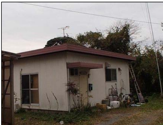
簡易鉄骨造平屋
