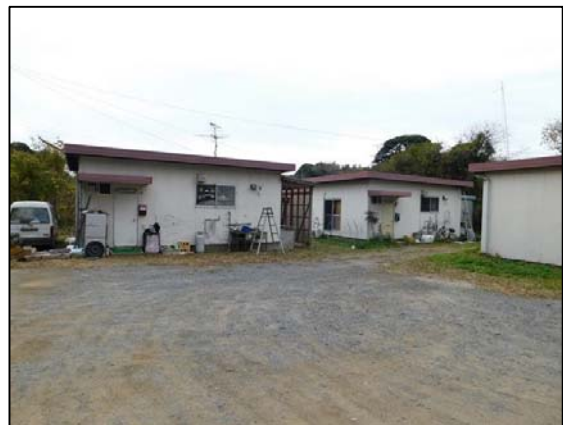
簡易鉄骨造平屋
