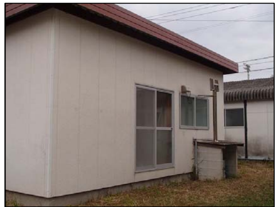
簡易鉄骨造平屋
