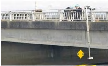
懸垂型カメラを用いた橋梁点検
