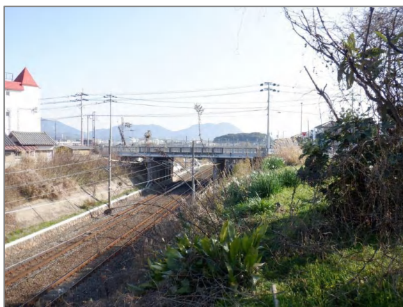
日の里大橋（跨線橋）
