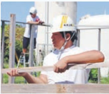
建設現場で解体作業
