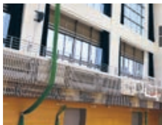
城山中学校体育館に設置された空調
