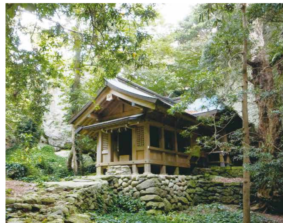
宗像大社 沖津宮(本殿・拝殿)の様子
