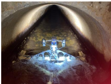
（写真 1 大口径 TV カメラ調査）
