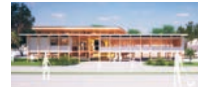
木造平屋建て(施設面積1,361㎡)
