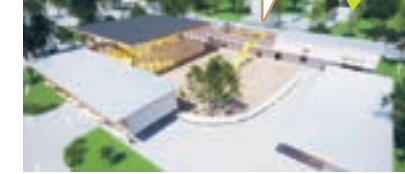
芝生広場の一角に建設中
