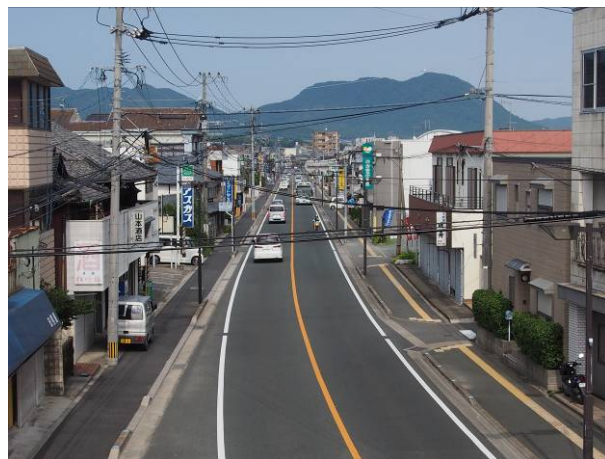
▲県道 97 号（田熊付近）
